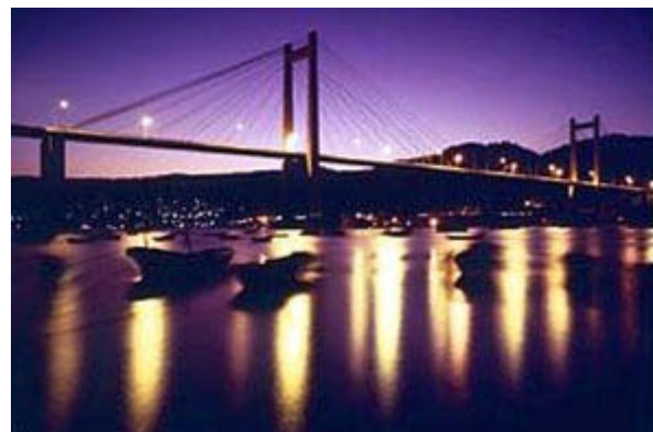
Vista Nocturna del Puente de Rande
